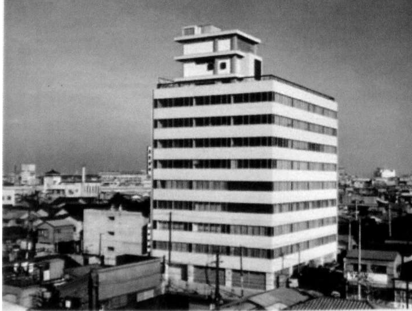
友愛会館竣工 昭和 39 年 12 月 (地上 9 階、地下 2 階)
