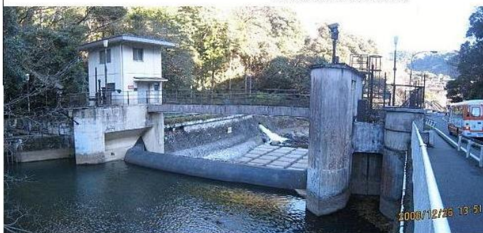
東京電力早川取水堰
