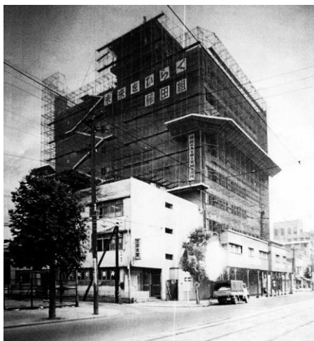
1964年、工事中の三田会館の隣に建っている「芝園食堂」=焼け残り修復再利用「青雲荘アパート」の姿
