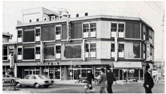
防災建築街区新築当時の太田メリヤス会館 1970年
