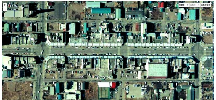
太田駅南口防災建築街区共同建築群完成の頃 1975年
