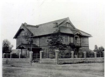
惟一館（1914年献堂式の直前に撮影された建築家の写真館蔵（タ））
