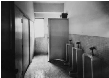
青雲荘アパートメントの便所
